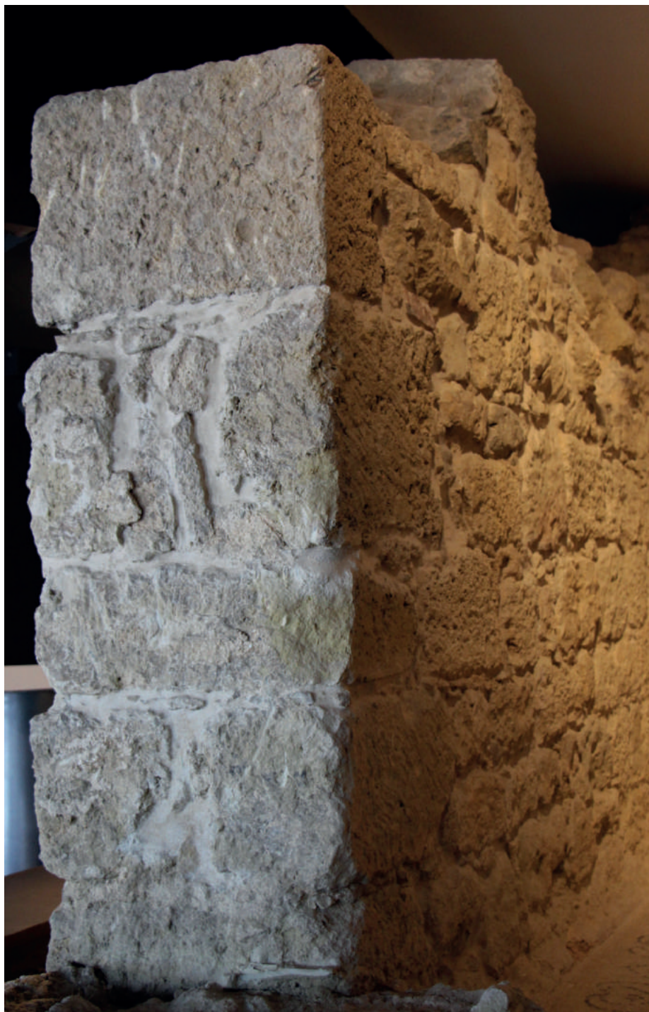
FIG.28 Fecho do muro do Compartmento 2 da domus identificada nos antigos Armazéns Sommer, realizado com blocos alternados em perpiano (© Pilar Reis).
