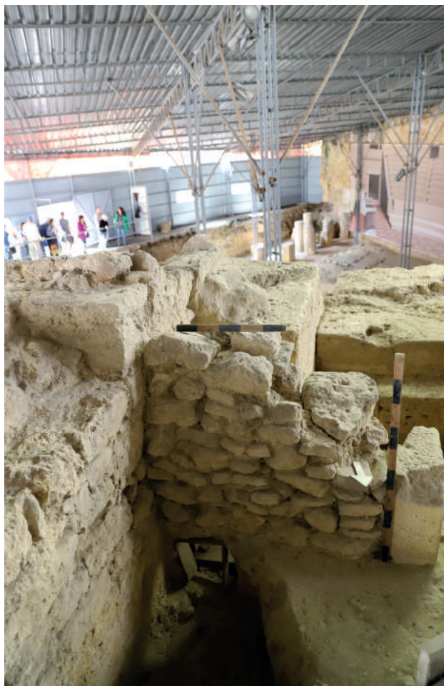
FIG. 10 Estrutura em opus mixtum construída no interior do vomitorium do teatro (face norte da estrutura sul) (© José Avelar – Museu de Lisboa / EGEAC).
