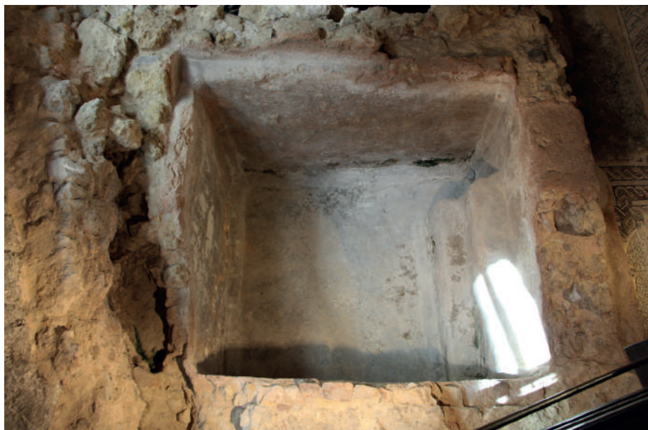
FIG. 24 Piscina com aparelho em opus incertum e opus testaceum (© Pilar Reis).
