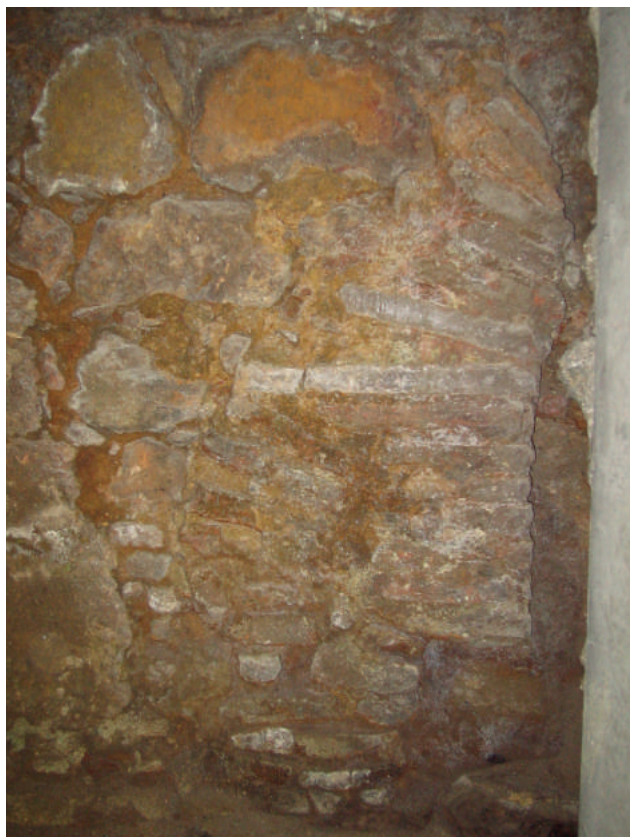
FIG. 20 Opus testaceum do hypocaustum das termas dos Cássios. Parte de arco em tijoleira associada a parede de alvenaria (© Pilar Reis).
