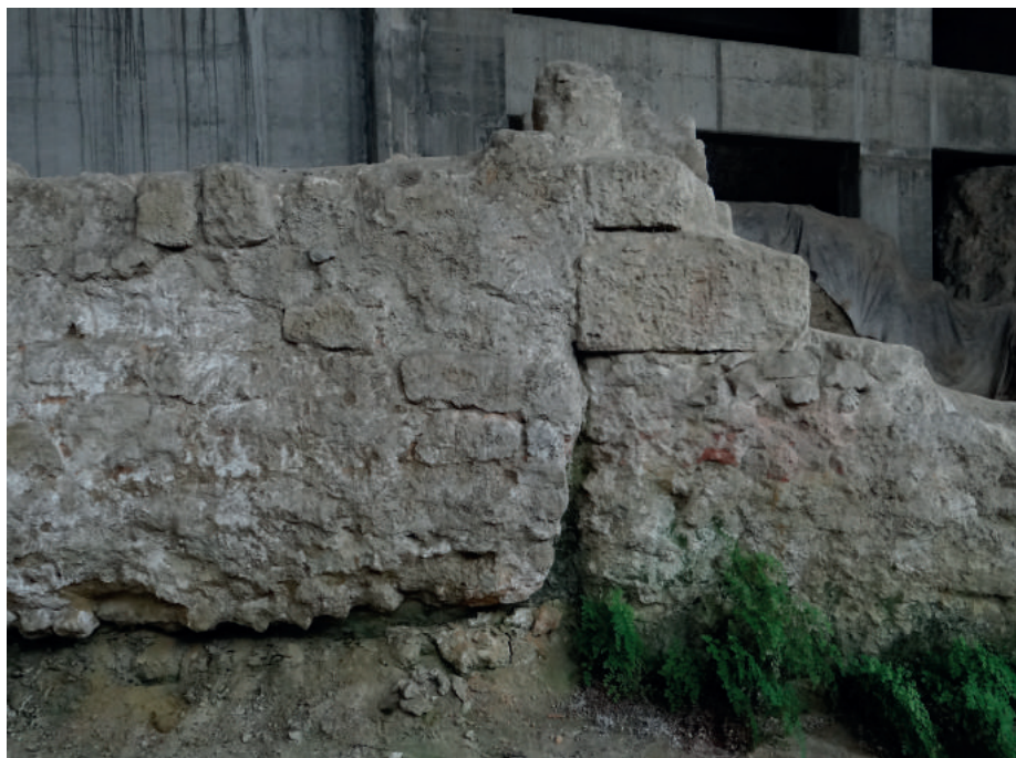
FIG. 21 Dois aparelhos distintos de duas estruturas adossadas, que empregam opus incertum (© Pilar Reis).
