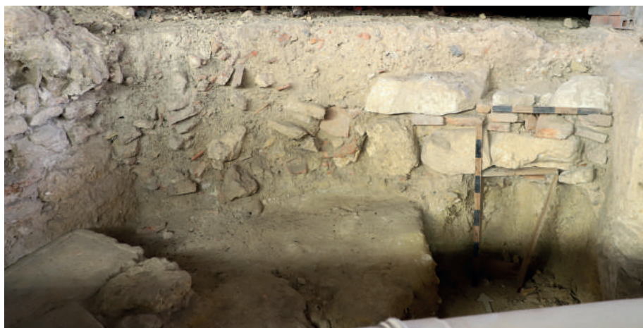
FIG. 11 Estrutura em opus mixtum construída no interior do vomitorium do teatro (face sul da estrutura norte) (© José Avelar – Museu de Lisboa / EGEAC).
