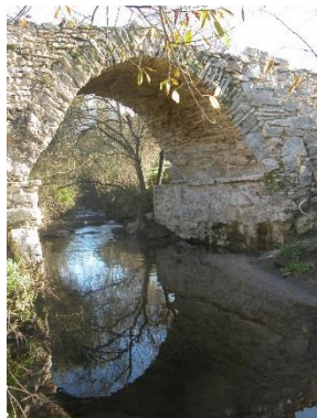
Fig. 3 - Ponte da Catribana (MASMO/CMS).
