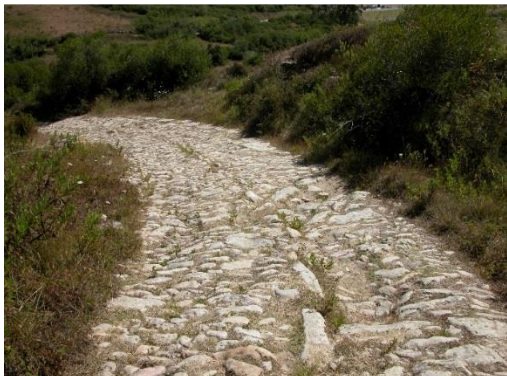
Fig. 4 - Calçada da Catribana (MASMO/CMS).
