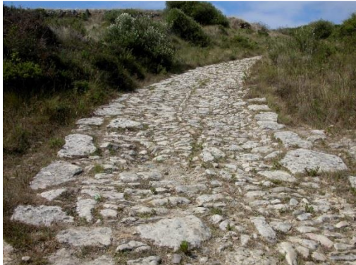
Fig. 5 - Calçada da Catribana (MASMO/CMS).
