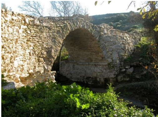
Fig. 2 - Ponte da Catribana (MASMO/CMS).
