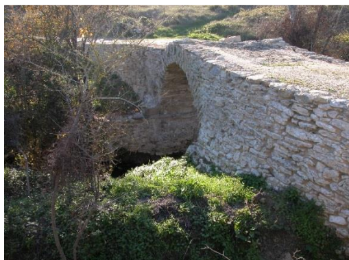
Fig. 1 - Ponte da Catribana (MASMO/CMS).
